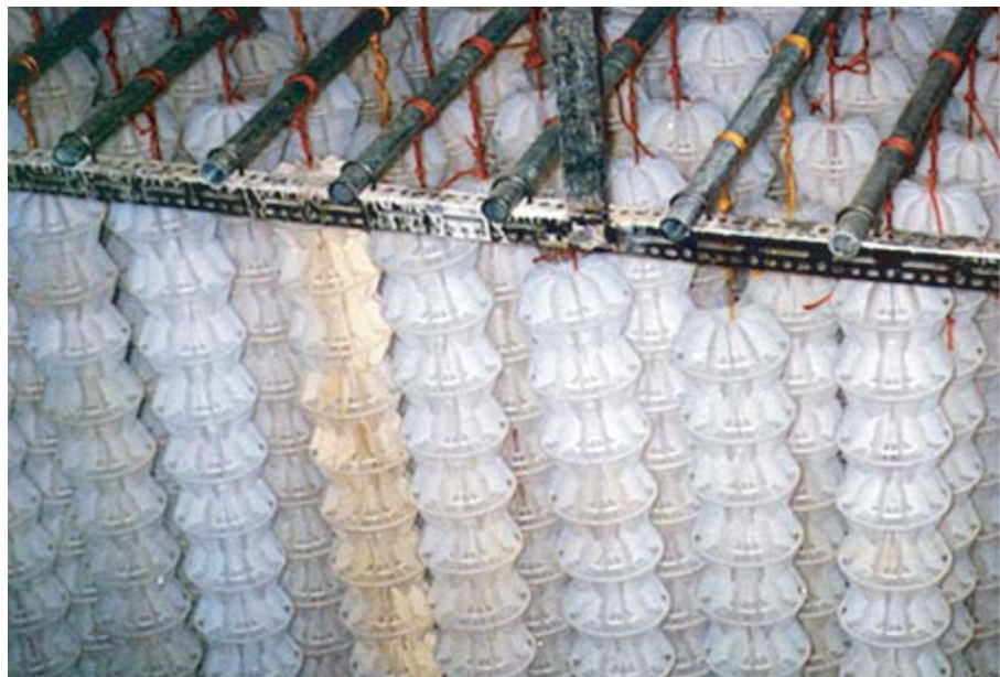
好浮流動式生物接觸濾球實際運用圖
